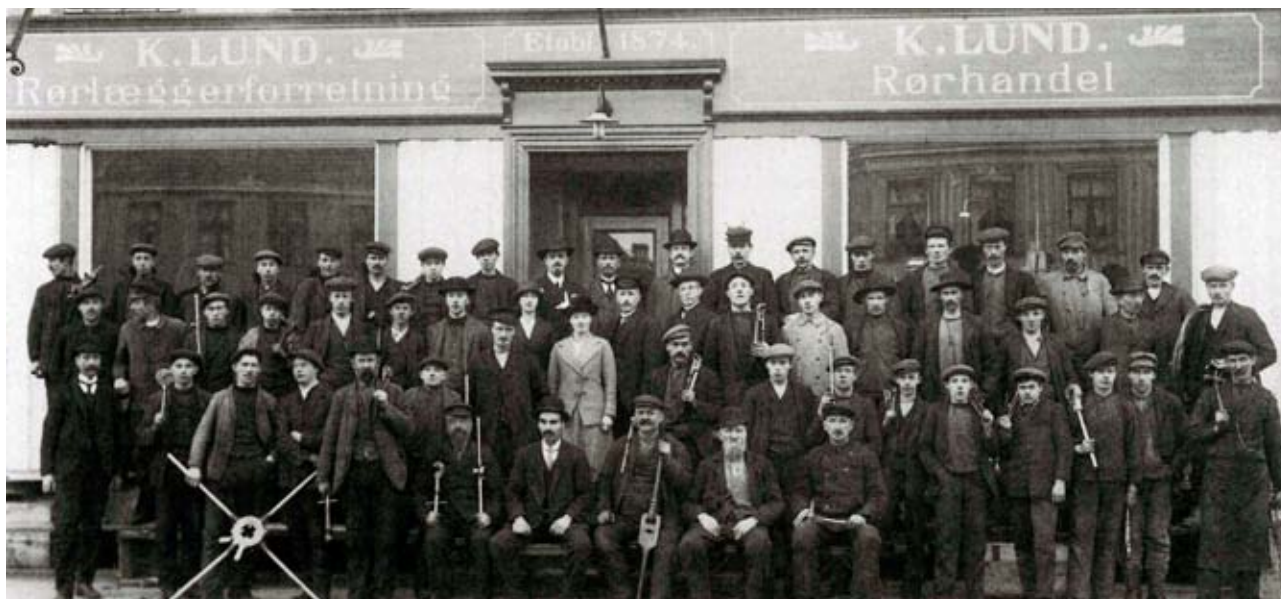
Byens første vannklosett ble sannsynligvis montert av en av disse karene, i 1899. Ansatte i K. Lund for rundt 100 år siden, utenfor kontoret i Dronningens gate 21-23.
